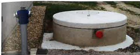
Zum Schutz vor Verunreinigung durch Straßenschmutz und Schlamm durch Unwetter wurden auf den Feuerwehrbrunnen ein Ring und ein Deckel gesetzt. Im Zuge dessen wurde auch das Ansaugfallrohr umgebaut.
